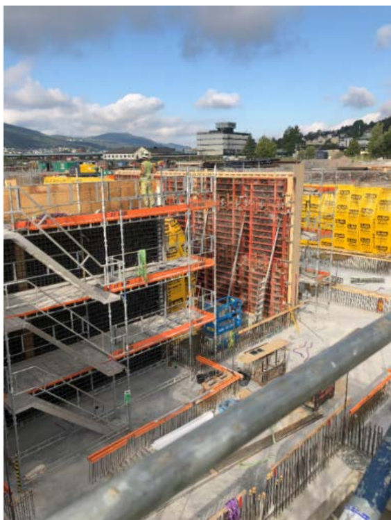
Bilde 1: Bilde fra byggeplass 2. tertial 2020, nytt sykehus i Drammen, Vestre Viken HF.
