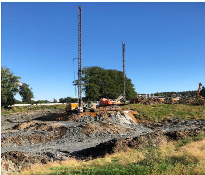
Bilde 4: Byggstart for nybygg psykisk helsevern Kristiansand, Sørlandet sykehus HF.
