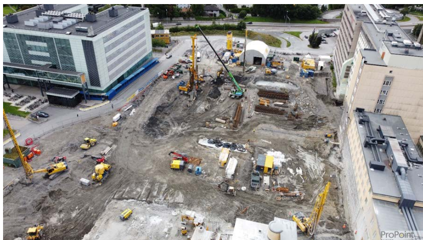
Bilde 3: Dronebilde fra 27.august 2020 av byggeplassen ved Radiumhospitalet, Oslo universitetssykehus HF.
